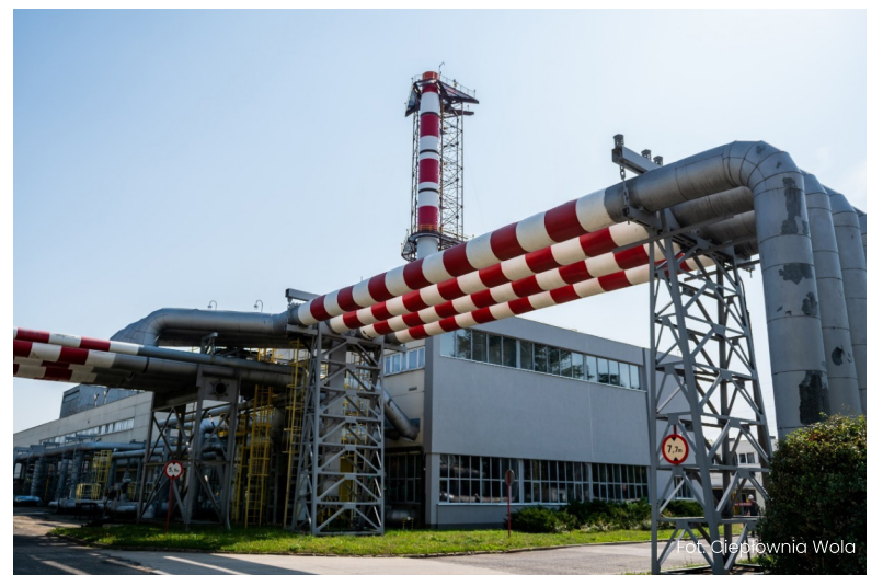
Ec Pruszków. Hala turbozespołów, pierwszy odbudowany i uruchomiony turbozespół 8 mW 1946 r. Fot. archiwalne
